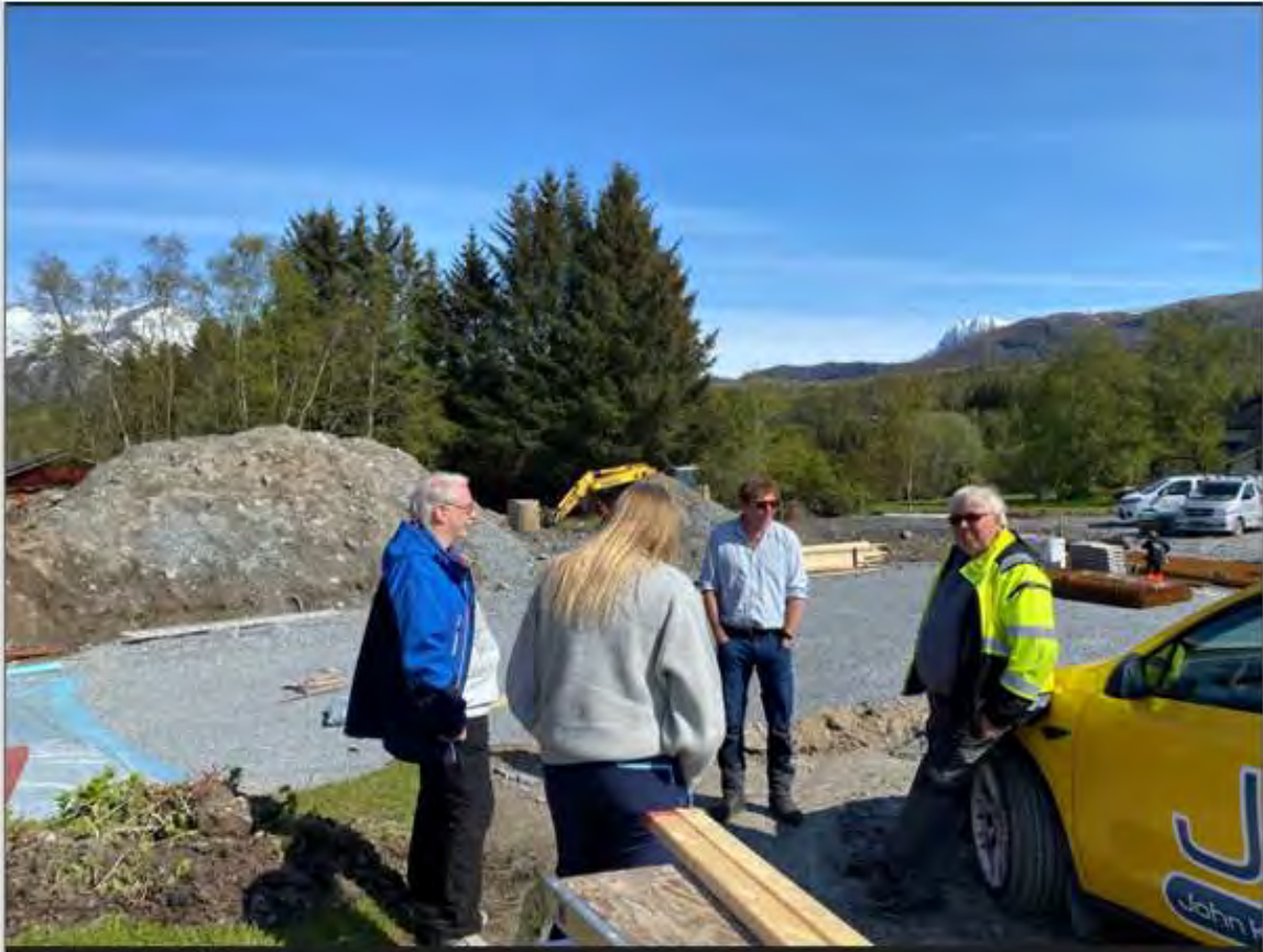
Bygging av fjør Halsos.
