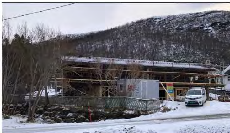
Ny bolig under oppføring, Åsveien 20
